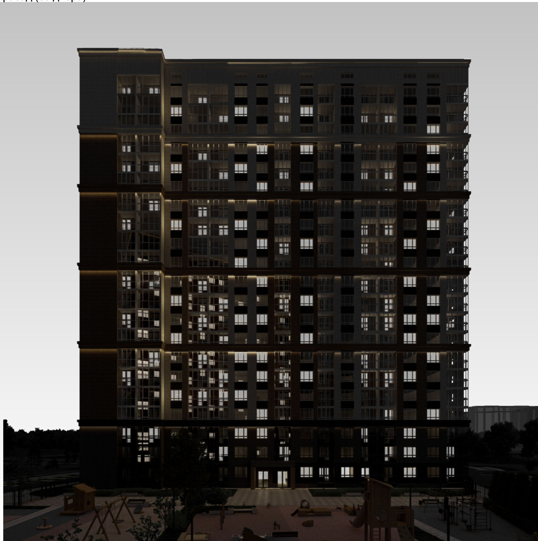
Позиция 18.1 восточный фасад (со двора)
